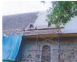
Depuis le printemps dernier, des travaux de réfection de la toiture de l'église et du passage de la sacristie ont été entrepris. Après avoir considéré le remplacement de la toiture de tôle à la canadienne par ce qui semble être le matériau d'origine, les bardeaux de cèdre, il fut choisi de reprendre le modèle de tôle à la canadienne.
